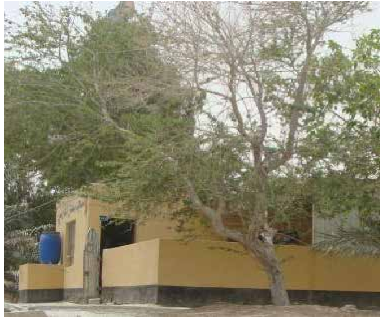
مسجد سلمان الفارسي في النويدرات (قبل إعادة البناء)
