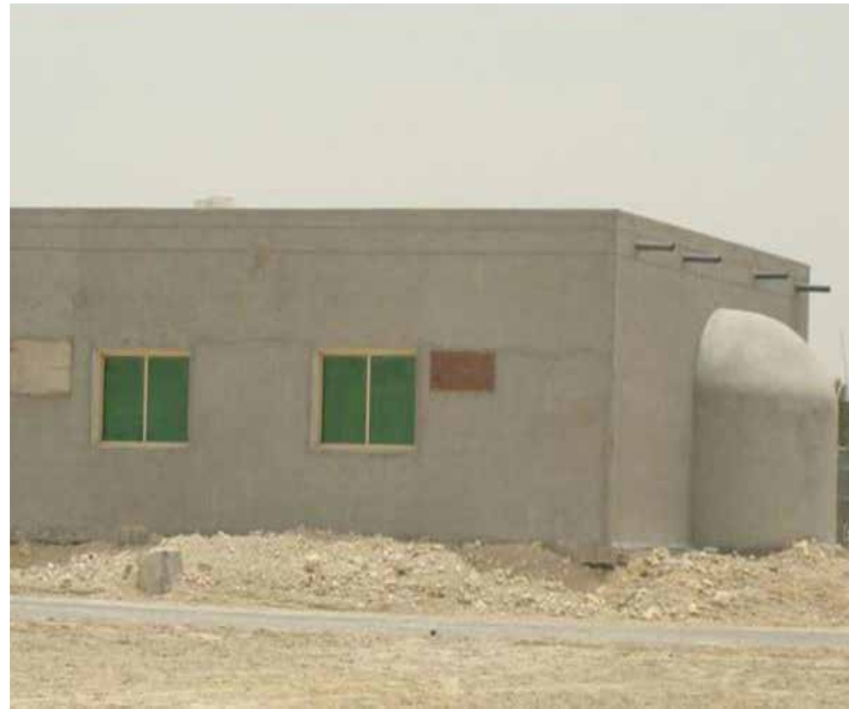
مسجد الإمام الصادق (ع) في النويدرات (قبل إعادة البناء) Imam Sadiq Mosque in Nuwaidrat (Before Reconstruction)
