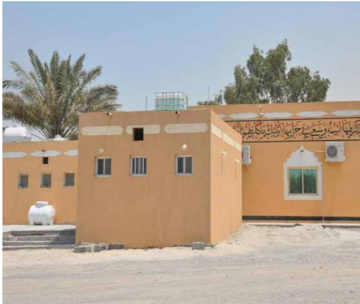
مسجد سلمان الفارسي في النويدرات (بعد إعادة البناء)
