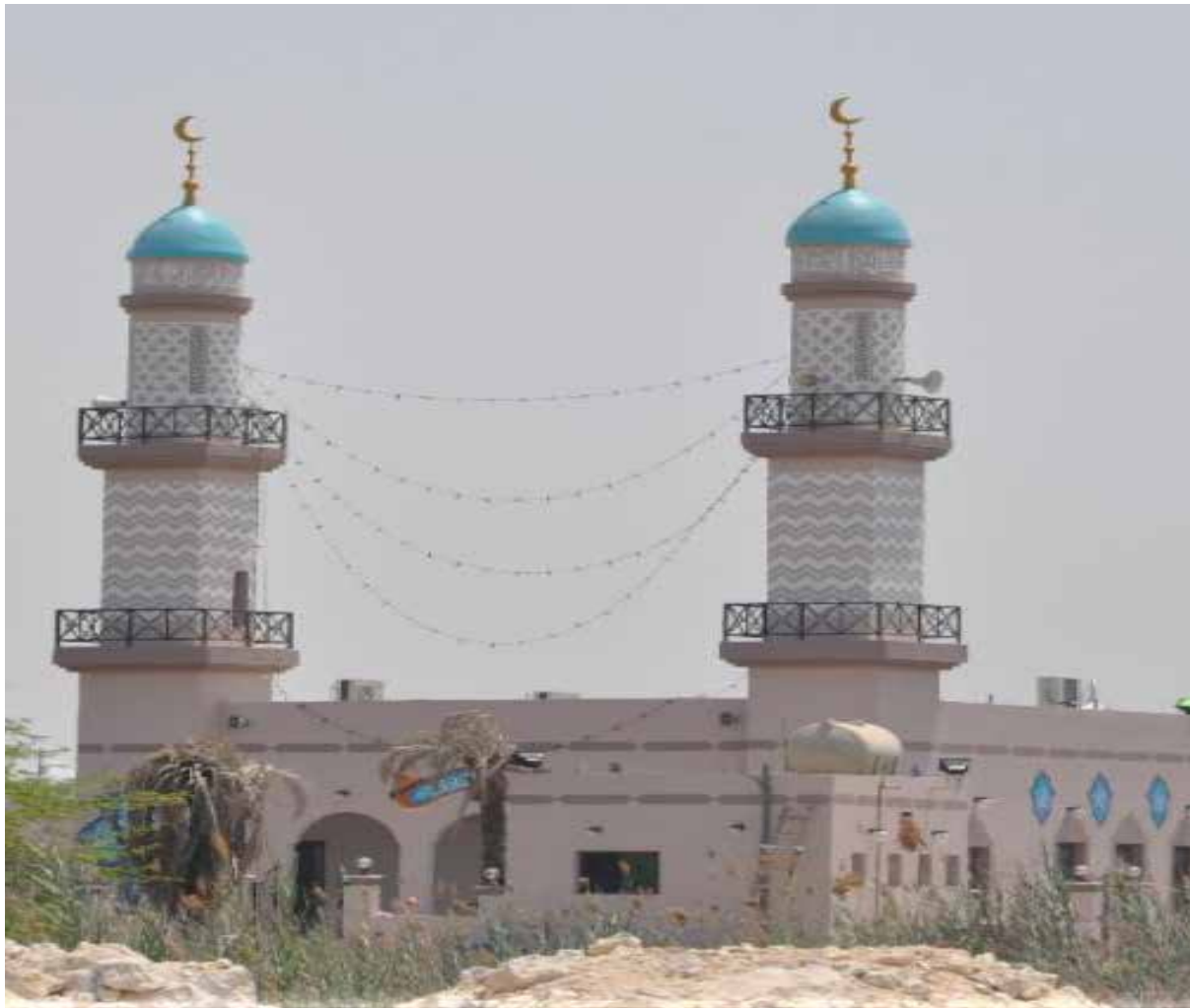
مسجد الإمام الهادي (ع) في النويدرات (بعد إعادة البناء)
