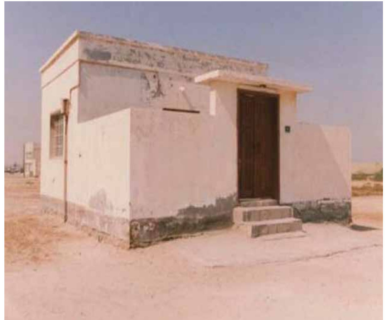
مسجد الإمام الصادق (ع) في سلماباد (قبل إعادة البناء) Imam Sadiq Mosque in Salmabad (Before Reconstruction)
